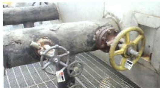
Figura 15 - Válvulas livres de vazamento, após o aperto utilizando SS
