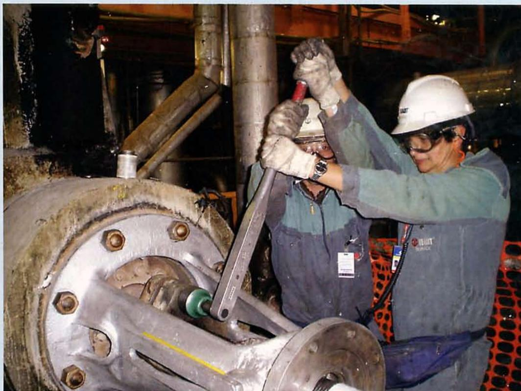
Engaxetamento de válvulas: coeficiente de aperto mínimo calculado
