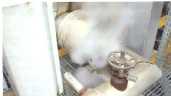
Figura 14 - Válvula vazando
